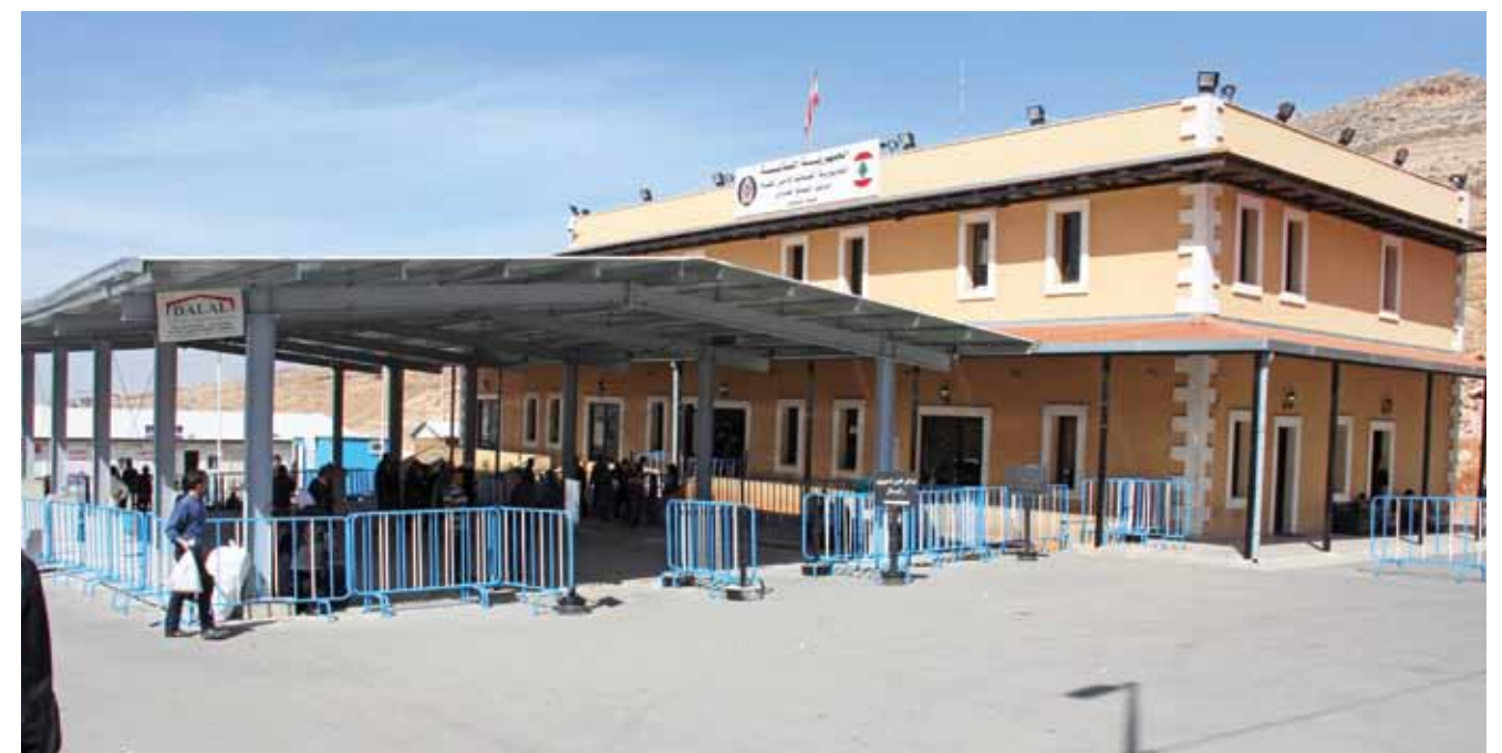
المبنى الجديد لمركز الامن العام في المصنع.
