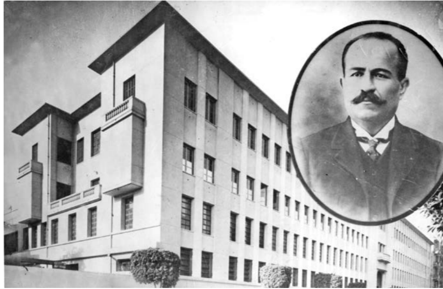
جرجي زيدان ومبنى "دار الهلال" في القاهرة.
