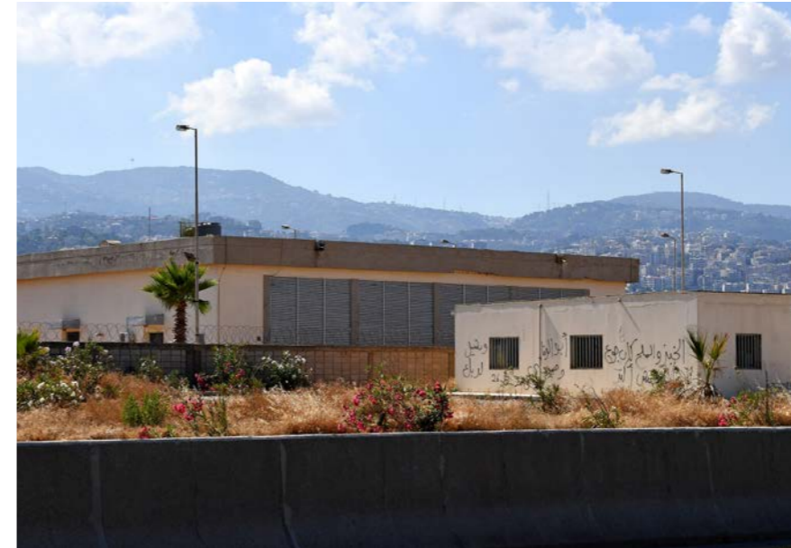
احدى محطات تكرير مياه الصرف الصحي جنوب بيروت.
