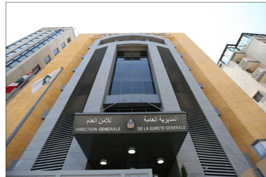
المبنى الجديد لمركز امن عام المتن الاقليمي.
